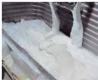
Обмерзання зовнішнього блоку без нагрівання піддону
